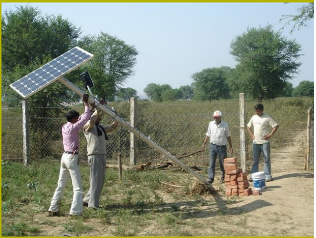
Installazione di un lampione solare
